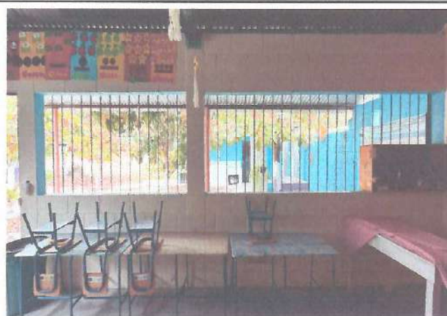
Foto 2: Reparación de Ventanas.
