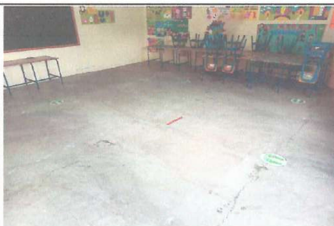
Foto 3: Repación de Piso de Aula.
